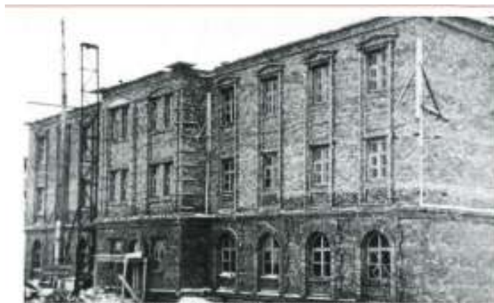
Единственное трехэтажное каменное здание в Дудинке в пятидесятые годы. Строилось Норильским комбинатом.
